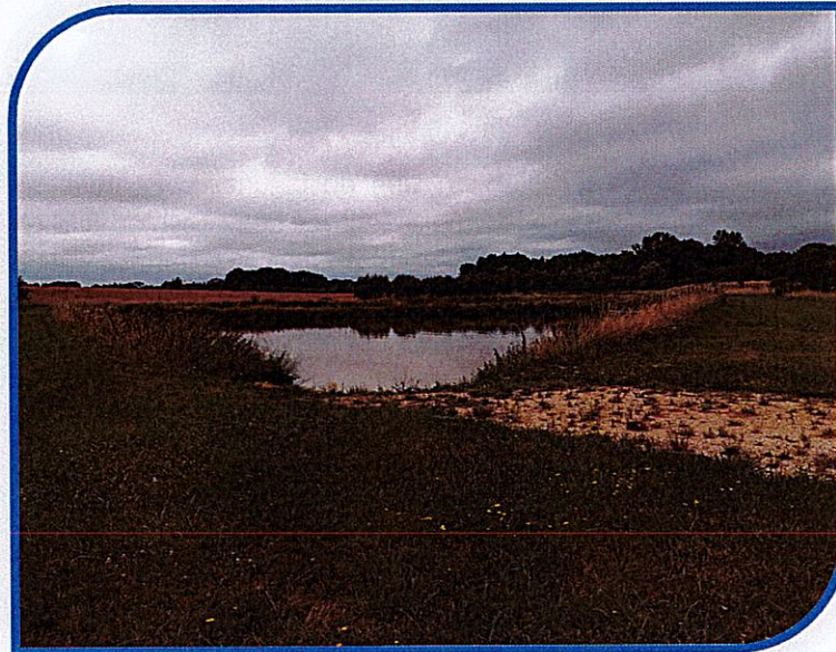
Photo : Bassin sur le site du lagunage
